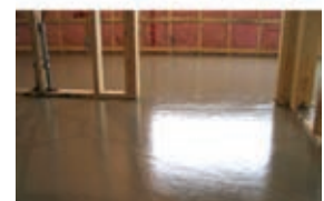
Un mortier autonivelant acoustique peut servir à la réalisation de chapes flottantes sur des structures de plancher neuves ou renouvelées destinées à recevoir tous les types de revêtements de sol.
