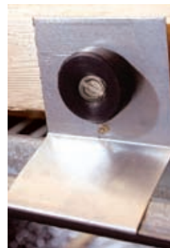
Aperçu du système d'ancrage acoustique Acoustivibe pour plafond de gypse fixé sur le côté des poutrelles ou des solives et sur lequel les fourrures sont suspendues.
